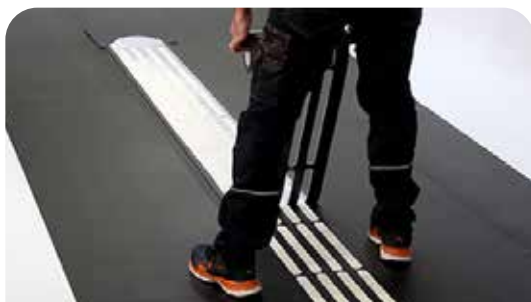
5 Après séchage complet, retrait en réenroulant le produit sur son mandrin pour limiter l'encombrement des déchets
